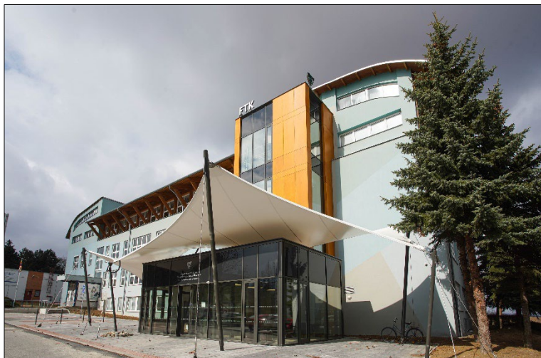
NA | budova děkanátu kontakt na vrátnici +420 585 636 080
